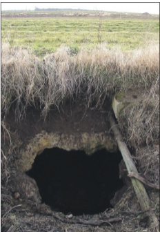
Der Zugang zur Hershheimer Unterwelt: Die Karsthöhle sehen viele in Gefahr, sollte die B 271 neu wie vorgesehen gebaut werden. FOTO: PRIVAT
